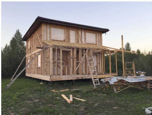
Возведение каркасного дома
