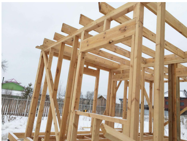
Установленные каркасные ячейки
