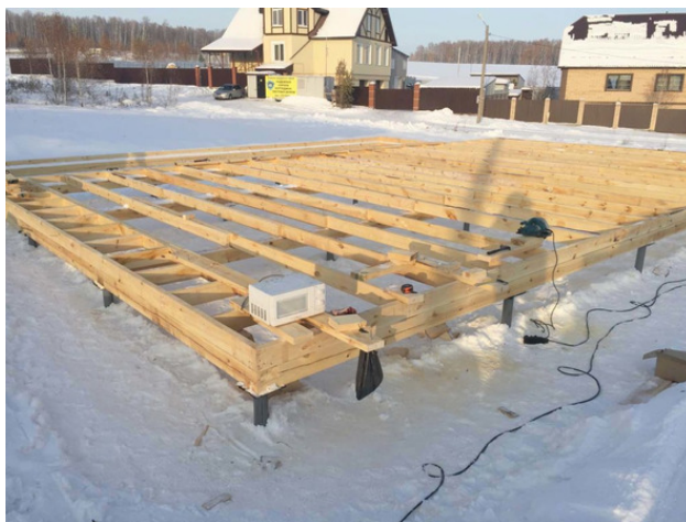
Фундамент на винтовых сваях
