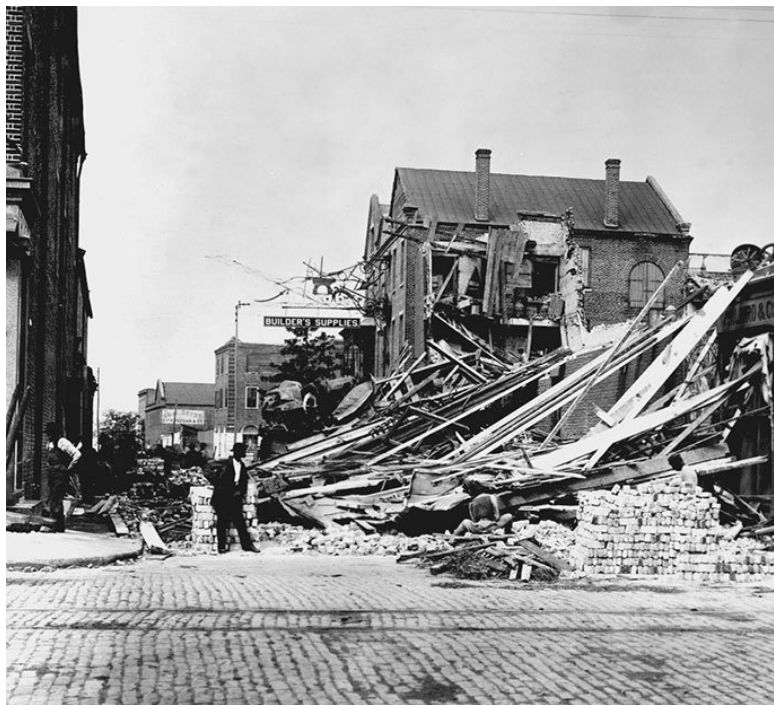
На одном из перекрестков Чарльстона после землетрясения 1886 г.
