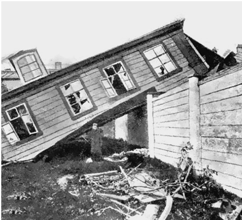
Один из московских домов, разрушенный ураганом 1904 г.
