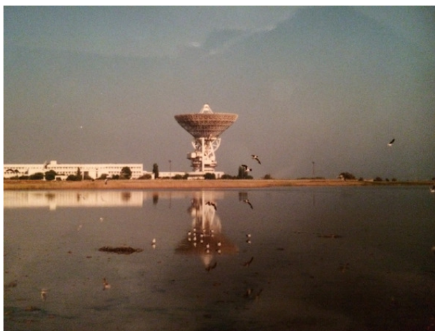
Центр дальней космической связи в районе г. Евпатория
