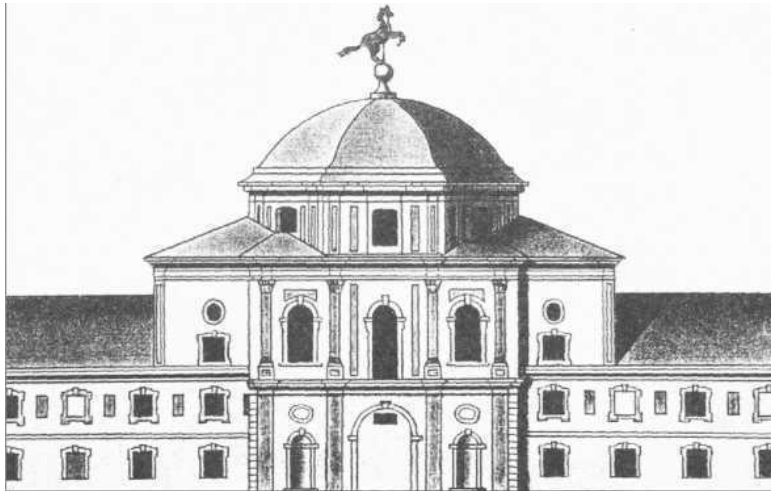
Придворные конюшни. Северный фасад. Фрагмент
