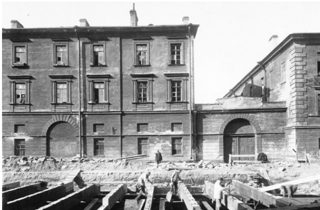
Разборка Перекрытия на канале Грибоедова. Фото 1926
