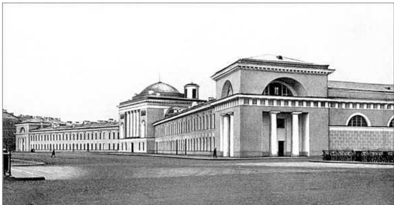
Придворные конюшни. Южный и часть восточного корпуса. Фото 1980-х гг.
