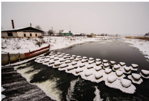
Водосброс Нердвинского пруда и река Нердва
