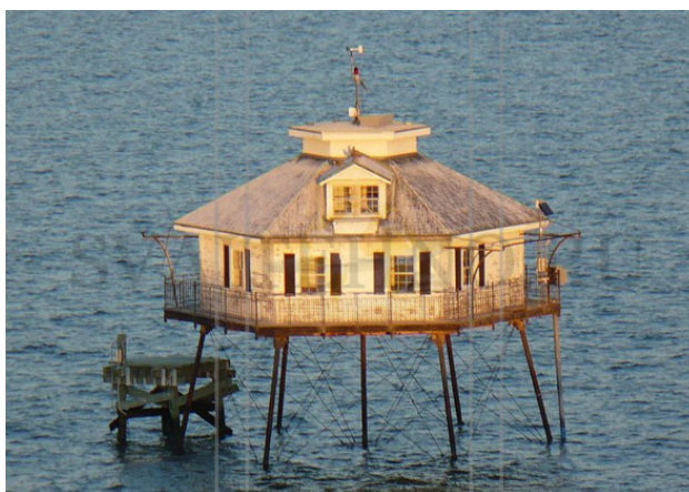
Надводное сооружение на винтовых сваях
