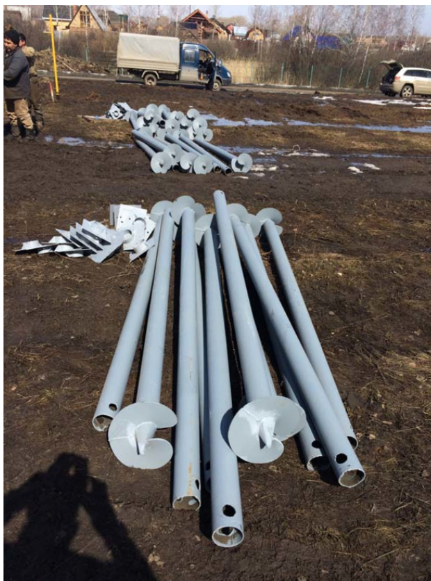
Винтовые сваи на месте монтажа
