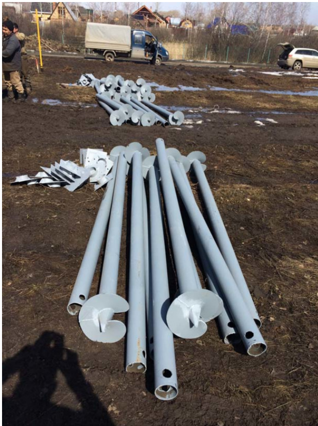
Винтовые сваи на месте монтажа
