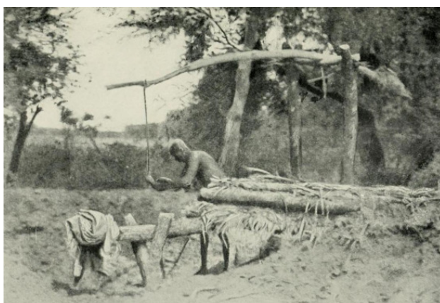
Туземный «насос» для перекачивания воды из одной оросительной канавы в другую
