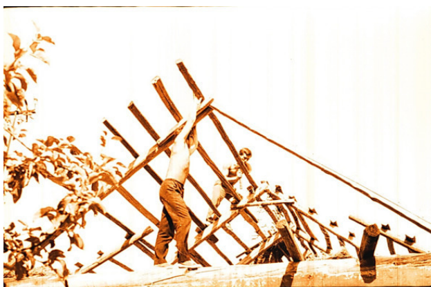
Стропила заменены, приколачиваем латы.
