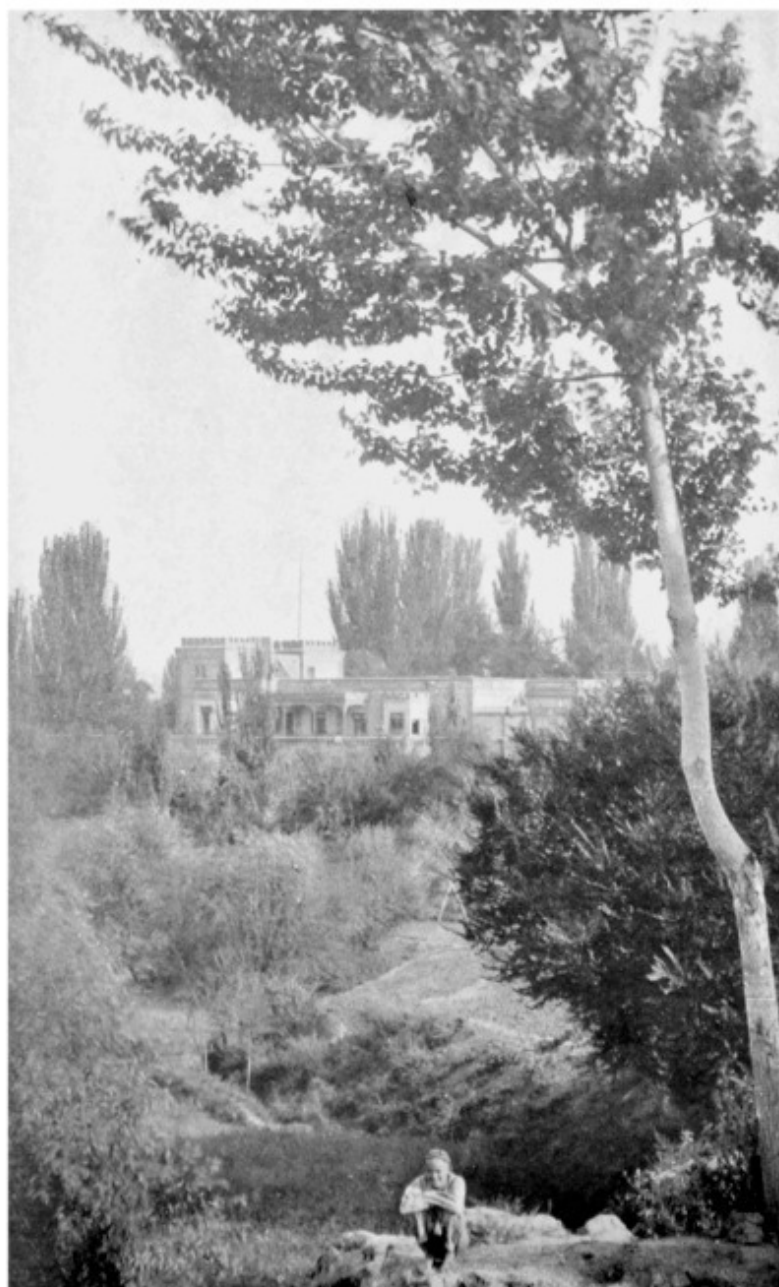
Британское Генеральное консульство в Кашгаре. Вид с западной стороны
