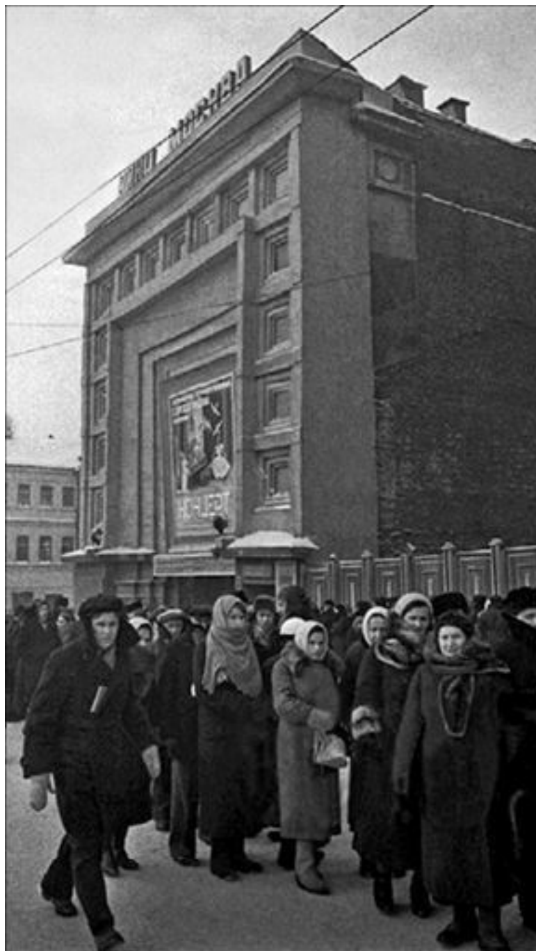
Кинотеатр «Москва» получил современную начинку для стереокино, еще не будучи встроенным в нынешнее здание.
