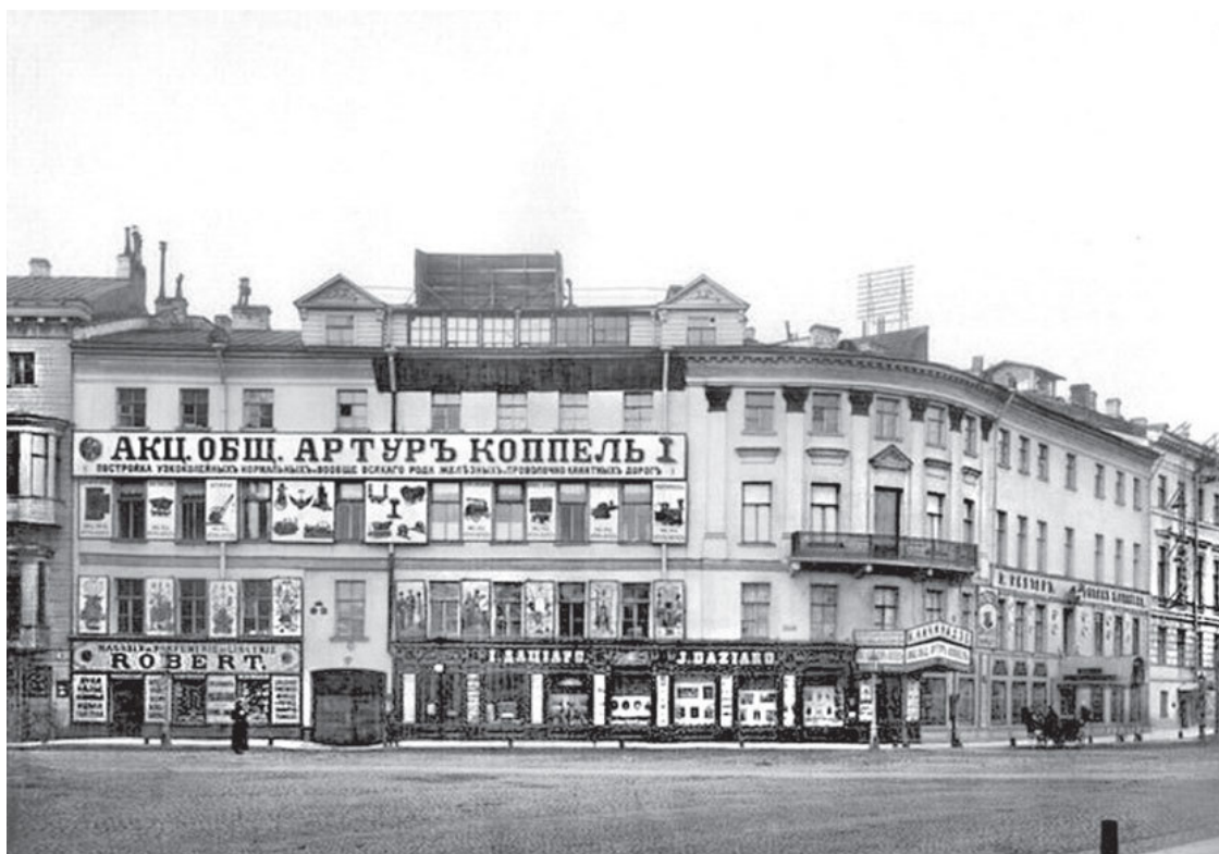
Дом Г. Гейденрейха до реконструкции
