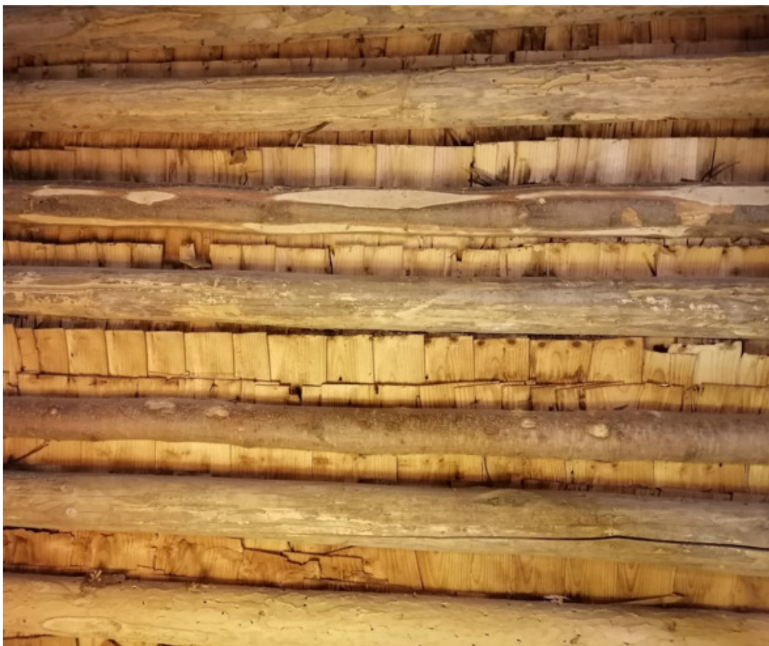
Старинная крыша из drankи на моём доме. Видны продольные нижние слои.
