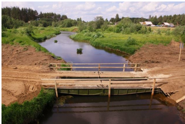
Фото №45 Временный мост при строительстве нового моста через р. Вохтома, 2015
