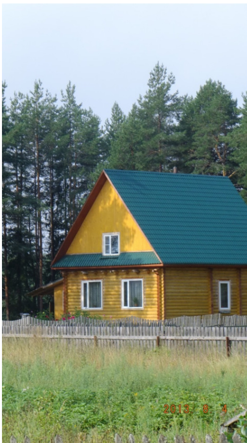
Фото №62 Дом Штурмановых, 2013
