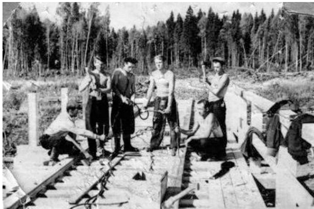
Фото №19 Строительство моста, 1950—60 гг.
