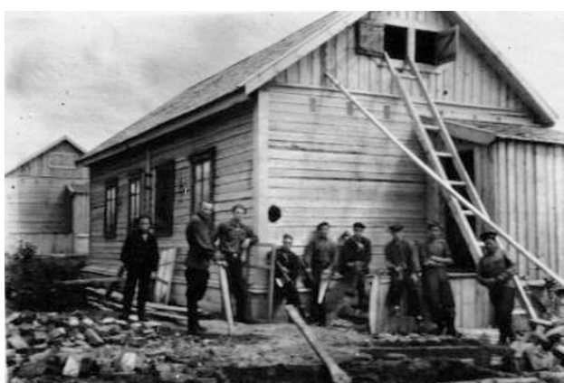
Фото №35 Строительство жилого дома на ул. Первомайская, 1953
