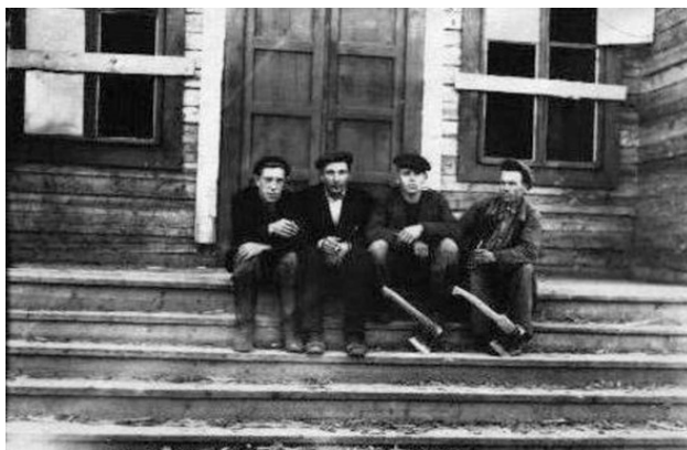
Фото №34 Строительство клуба, 1956. Здание сгорело в 2006
