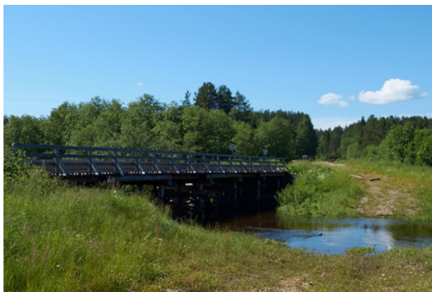
Фото №46 Мост через реку Вохтома, 2015
