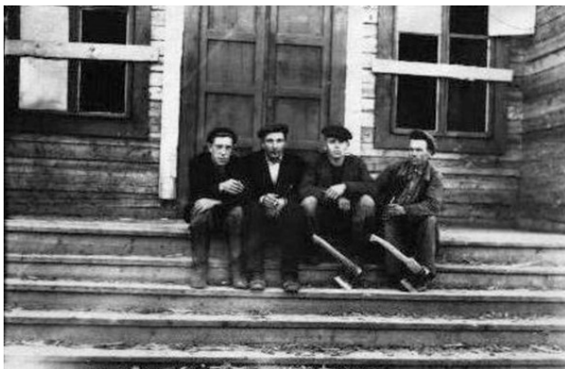
Фото №34 Строительство клуба, 1956. Здание сгорело в 2006
