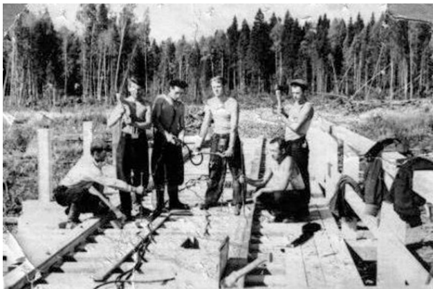
Фото №19 Строительство моста, 1950—60 гг.
