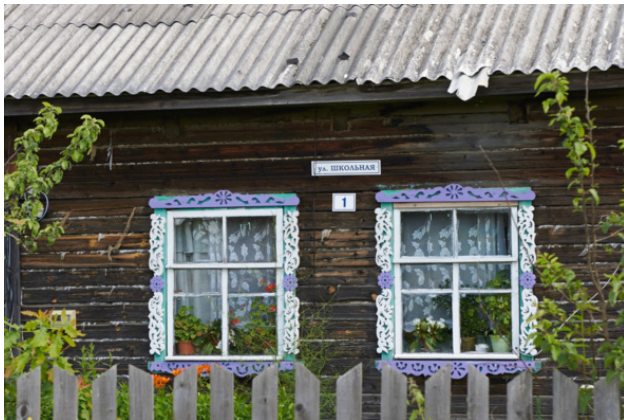
Фото №37 Дом на ул. Школьная
