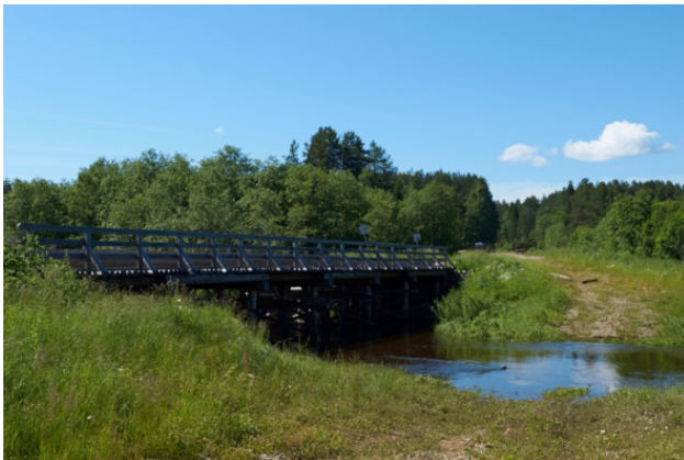
Фото №46 Мост через реку Вохтома, 2015
