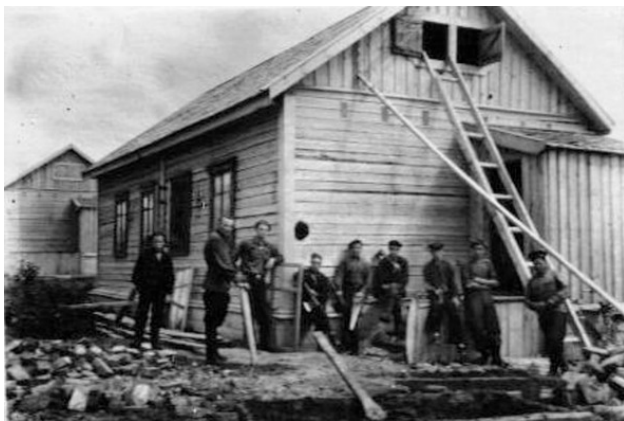
Фото №35 Строительство жилого дома на ул. Первомайская, 1953
