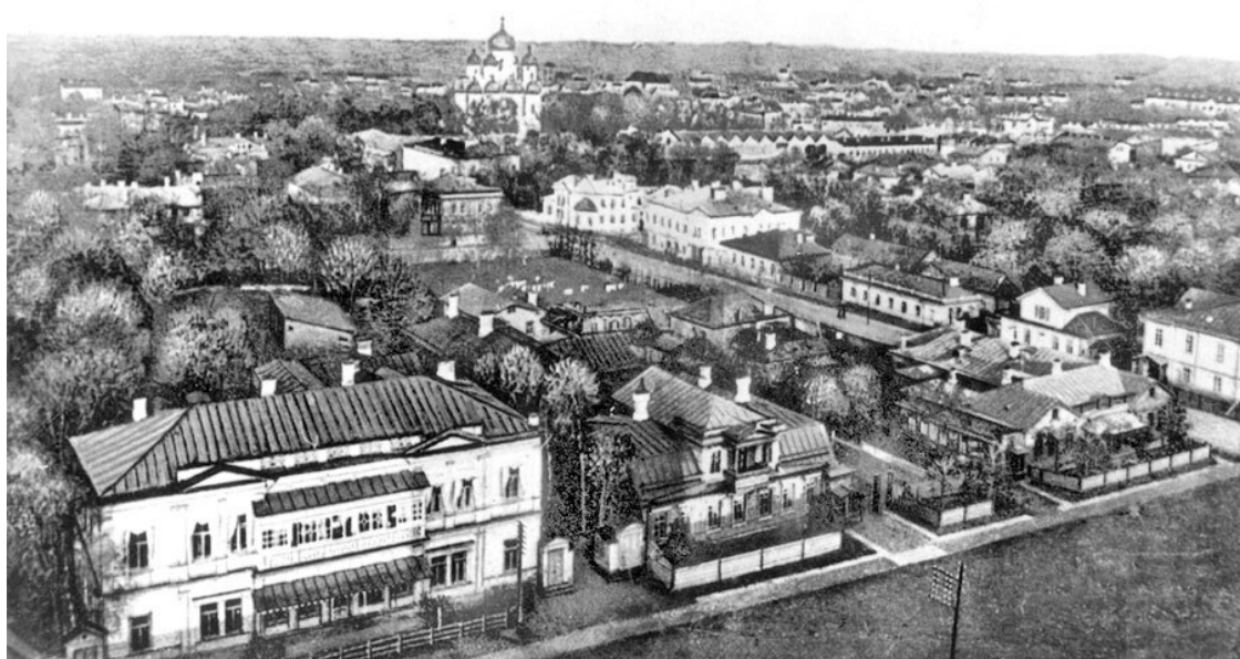
Вид на город с Водонапорной Певческой башни. Открытка 1910-х гг.
