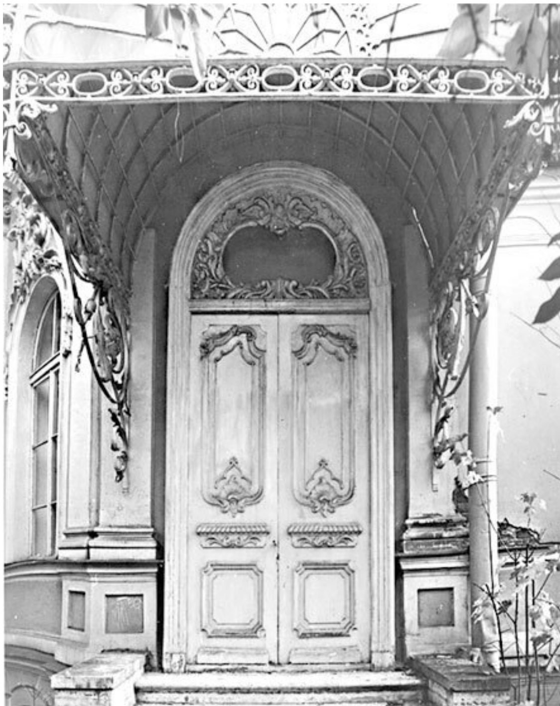
Вид входной двери
