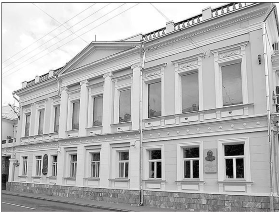
В этом здании по адресу Рождественский бульвар, д. 12/8, стр. № 1 находилась Лечебная комиссия Наркомздрава РСФСР/СССР
