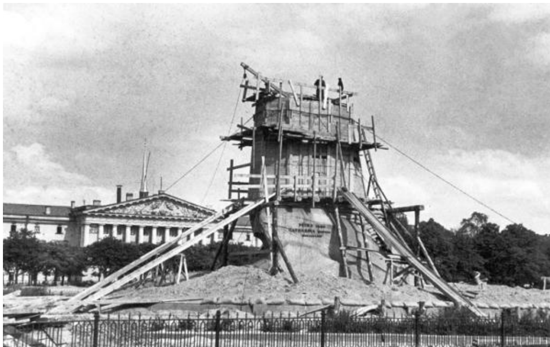
Памятник Петру I на площади Декабристов в защитном устройстве. Август 1941 г.
