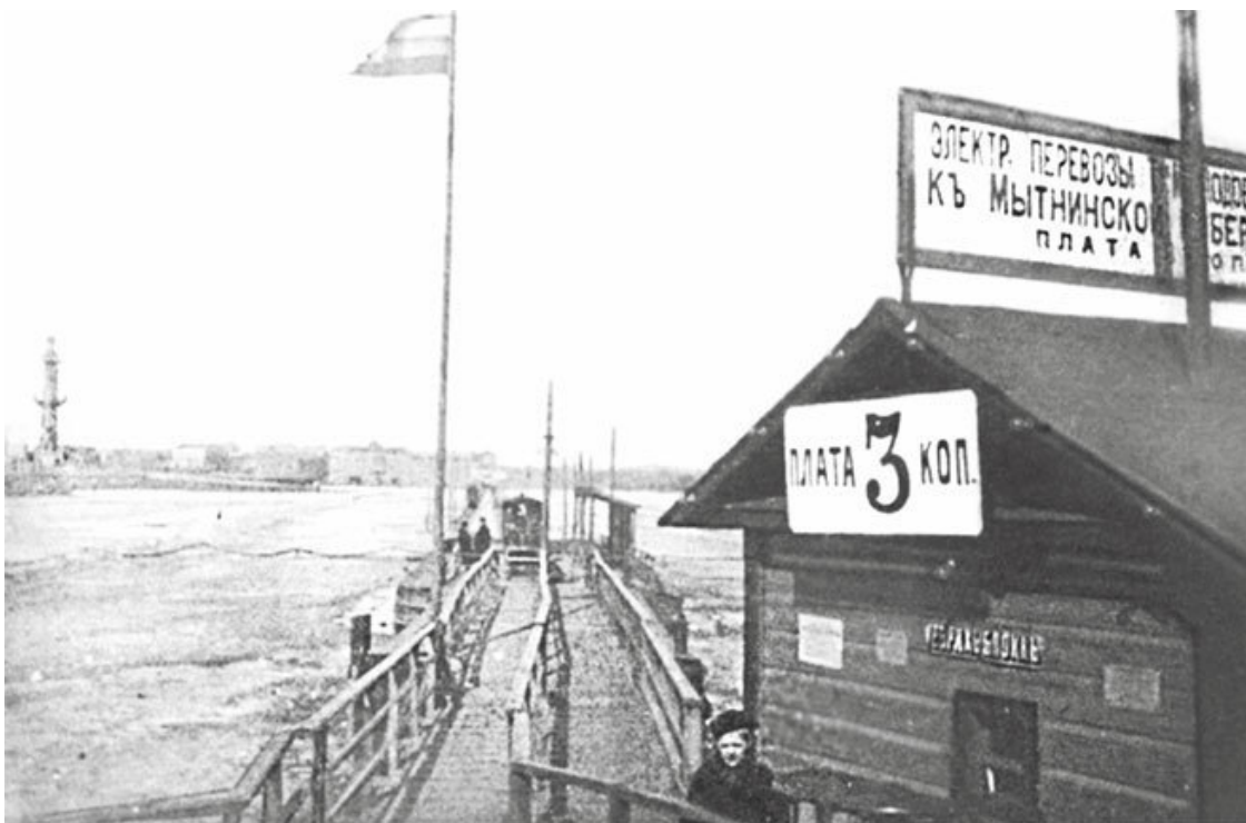
Линия электрического трамвая, соединявшая по льду Невы Дворцовую и Мытнинскую набережные. Фото 1895-1900 гг.
