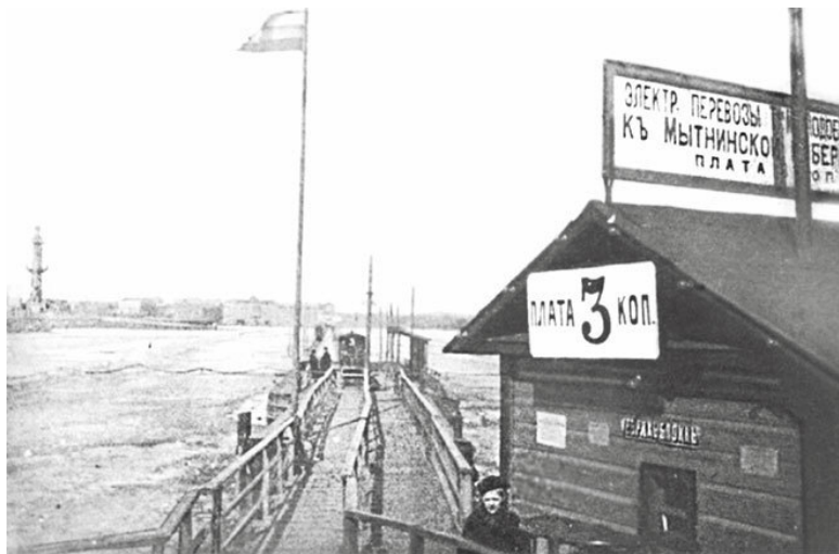
Линия электрического трамвая, соединявшая по льду Невы Дворцовую и Мытнинскую набережные. Фото 1895-1900 гг.
