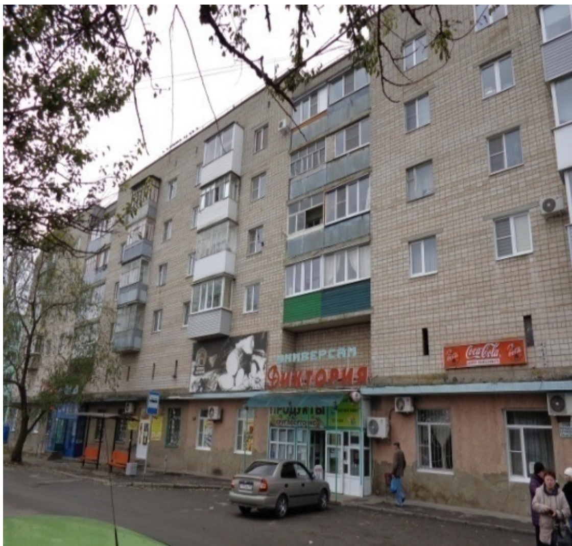
СЖМ. Типичный частный дом СЖМ. Металлургическая, 113
