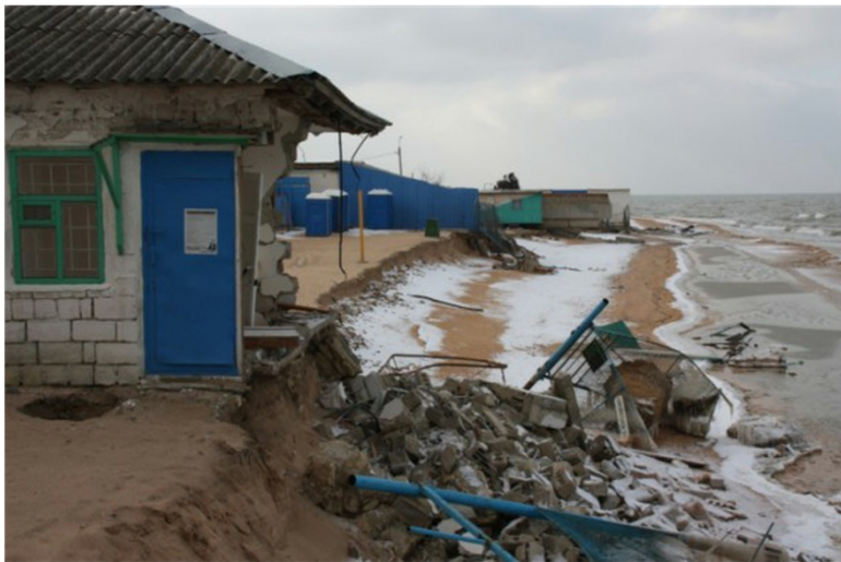
Рис. 1.3. Разрушение береговой линии и хозяйственной постройки на Таманском полуострове в результате нагона воды ( http://www.ucn.su/?p=8954 )
