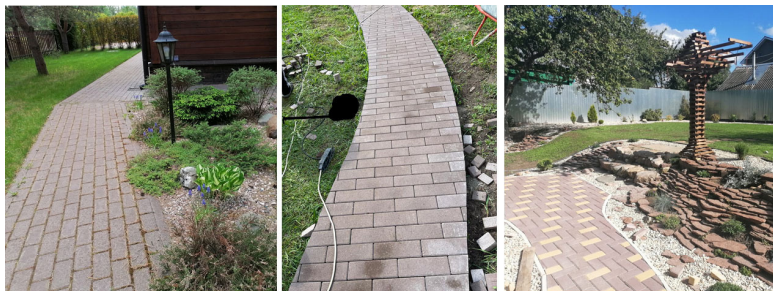
Рис. 1.12. Примеры мощения с различной укладкой брус-
