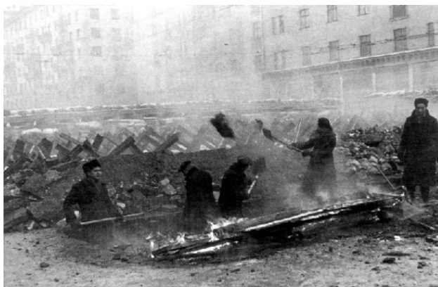
Возведение земляных укреплений на улицах столицы СССР
