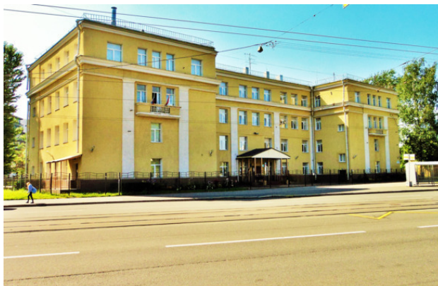
Современный вид бывшей начальной школы
