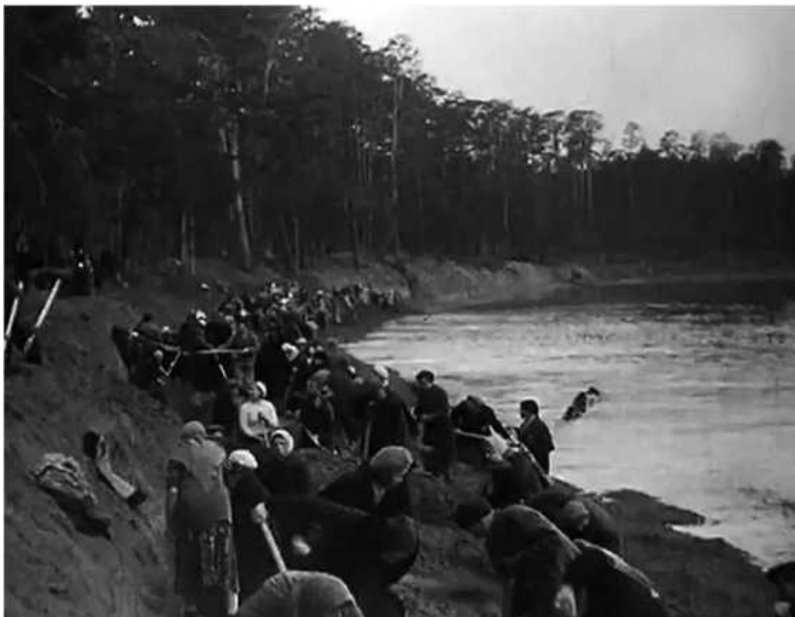
Жители Москвы на строительстве укреплений. В кадр попал процесс эскарпирования, вертикальной обрезки берега реки для затруднения ее форсирования
