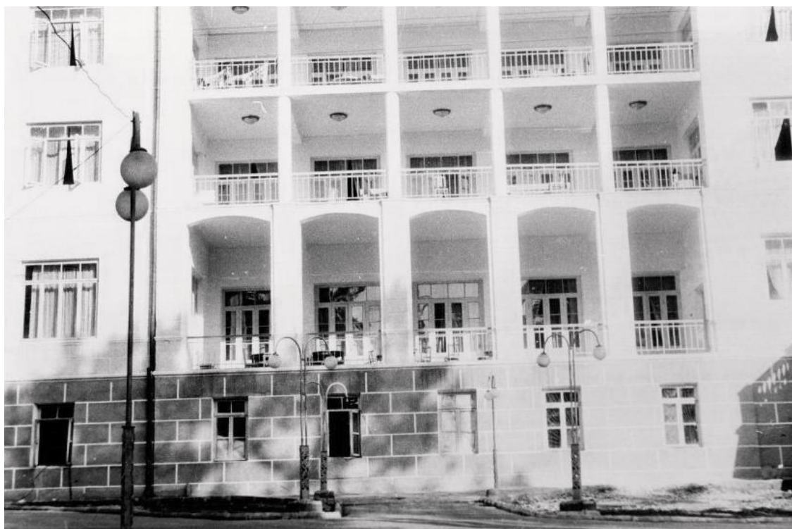
Это корпус пансионата, в котором мы провели свой отпуск в МАХИНДЖАУРЕ в 1961 году
