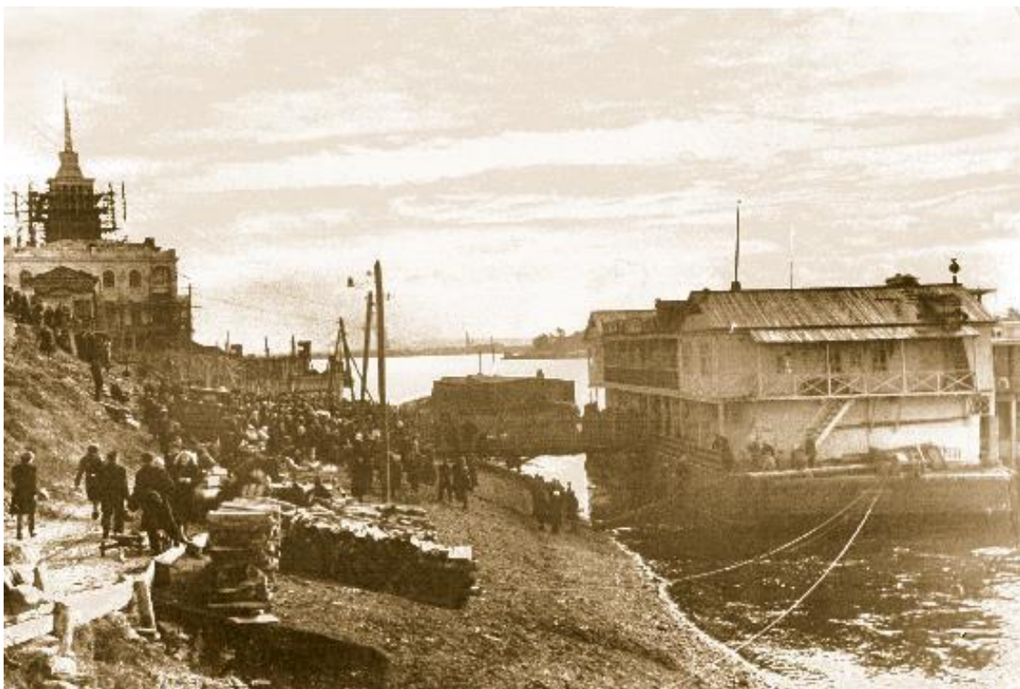
Строительство Красноярского речного вокзала, 1950 год
