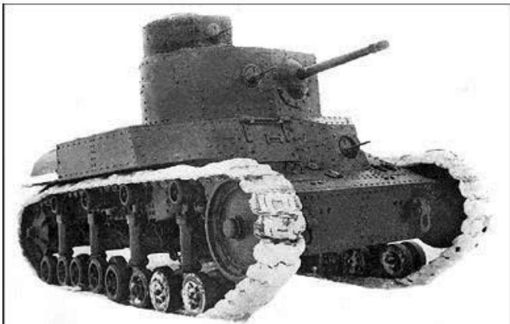
Средний танк Т-24, выпущенный небольшой серией
