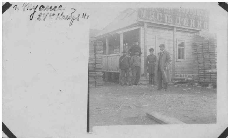
Магазин строительных товаров М. Я. Седенко, 24 ноября 1911 г., Туансе
