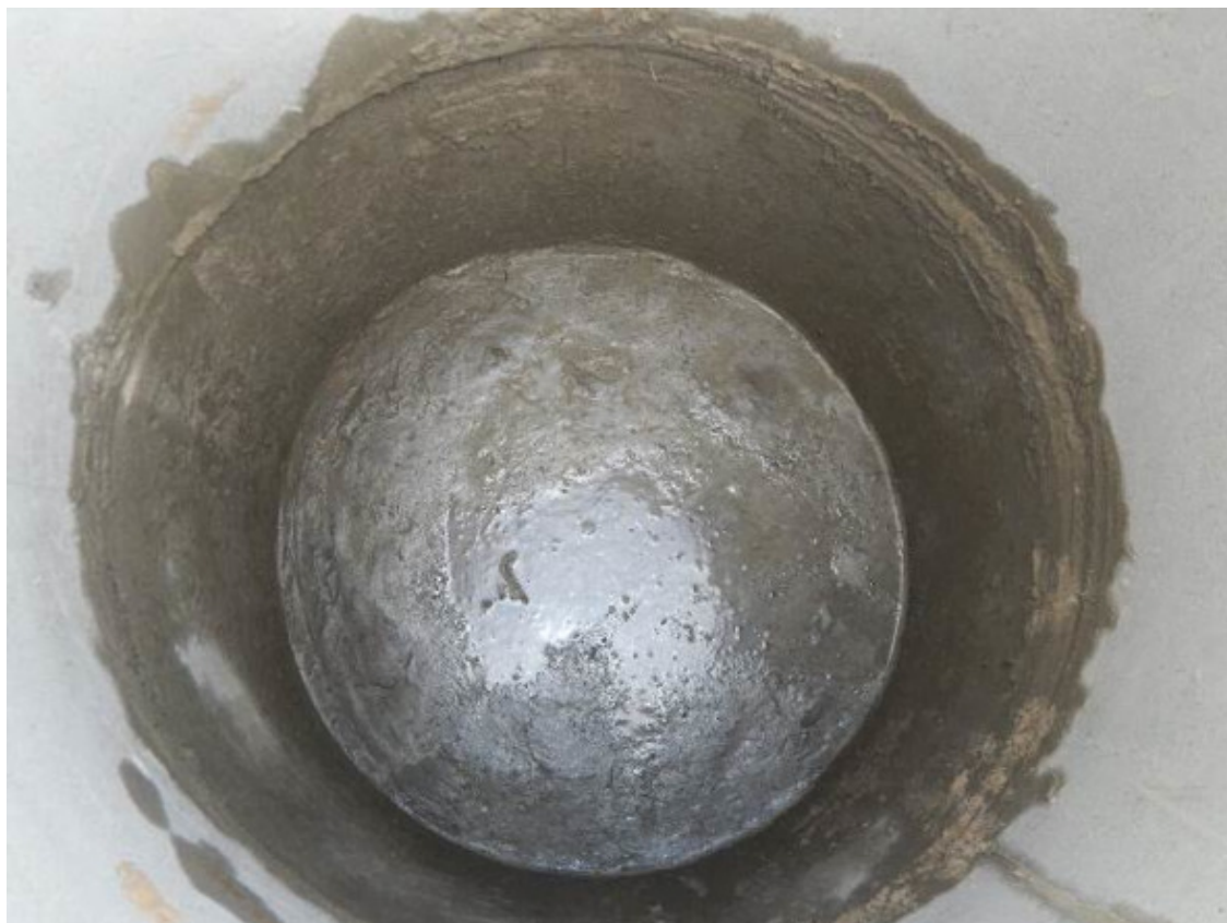
Замазка щелей и бетонирование дна погреба.
