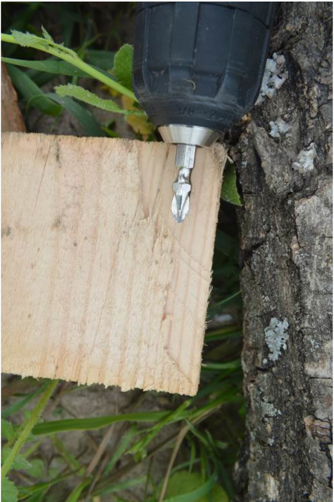
Шуруповёрт для крепления металлических уголков
