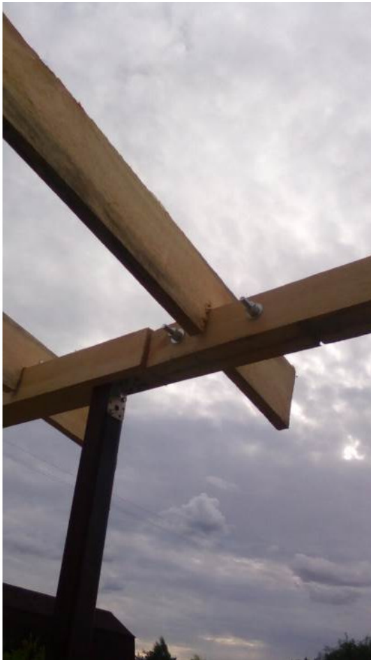
Сшивание балок болтовыми соединениями.
