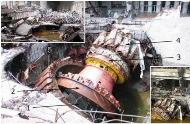
Рис. 4. Аварийное разрушение гидроагрегата №2
