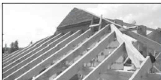
Часть стропильной плоскости с примыканием к вертикальной стене и ребру.
