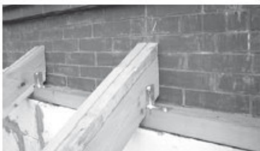
Способ крепления стропил стальными уголками.
