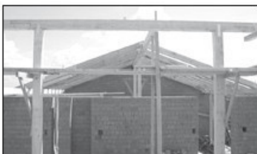
Монтаж опорных конструкций стропильной системы.
