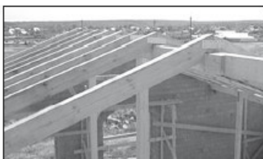
Монтаж стропил в зоне конька.
