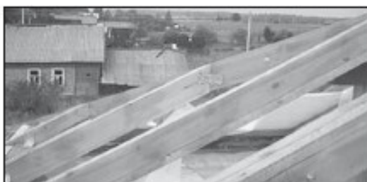
Крепление стропил стальными уголками в зоне ребра (хребта).
