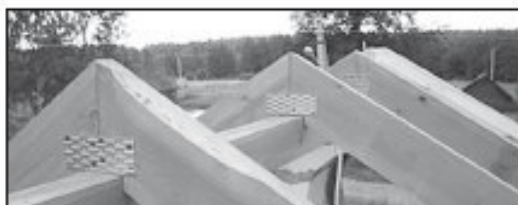
Крепление стропил в зоне конька стальными пластинами.
