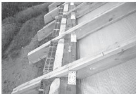
Крепление стропил в зоне мауэрлата.
