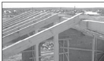
Монтаж стропил в зоне конька.
