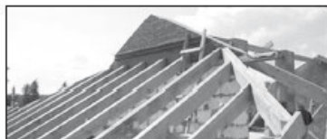
Крепление стропил в зоне конька стальными пластинами.
