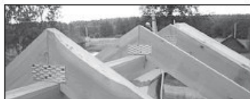
Крепление стропил в зоне конька стальными пластинами.
