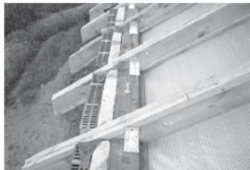
Крепление стропил в зоне мауэрлата.
