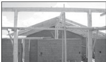
Монтаж опорных конструкций стропильной системы.
