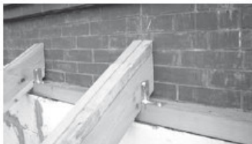
Способ крепления стропил стальными уголками.
