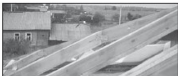
Способ крепления стропил стальными уголками.
