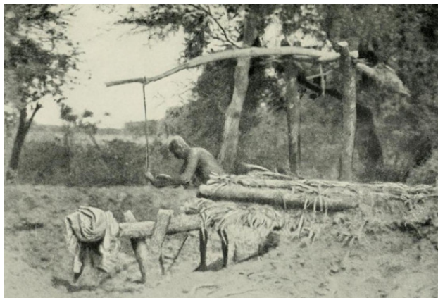
Туземный «насос» для перекачивания воды из одной оросительной канавы в другую
