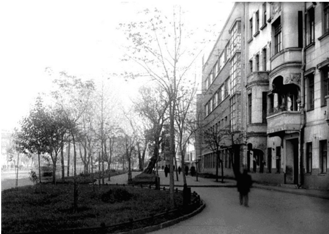
1933 г. Большая Садовая, дом № 10.
