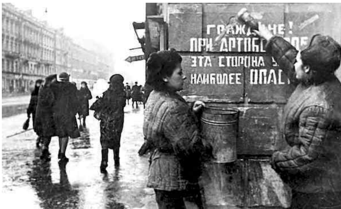
После снятия блокады на Невском проспекте убирают надписи «Граждане! При артобстреле эта сторона улицы наиболее опасна»
