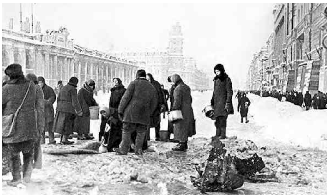
Жители набирают воду из разрушенного магистрального водопровода на углу проспекта 25 Октября (Невского проспекта) и Садовой улицы. Зима 1941/42 г.
