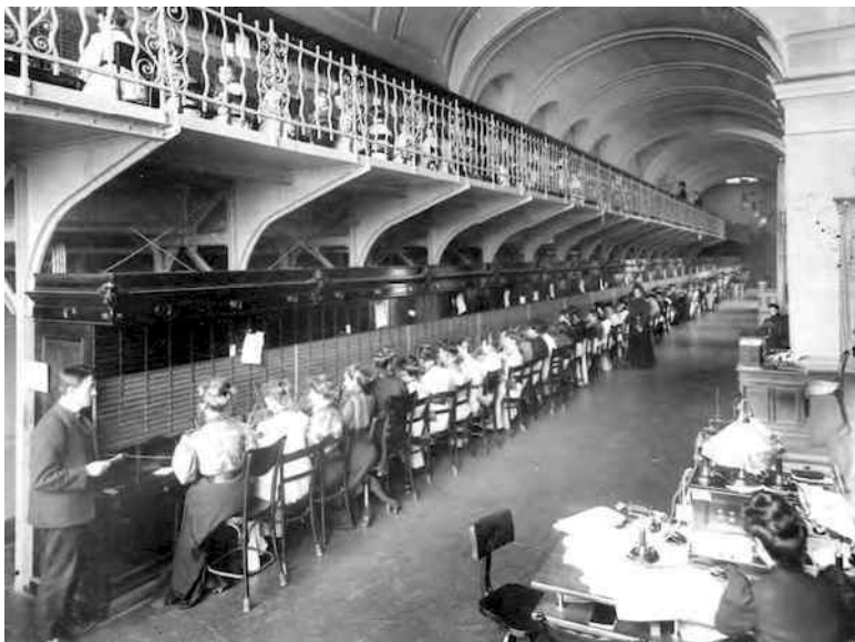
Операционный зал Петербургской телефонной станции. Фото 1900-х гг.
