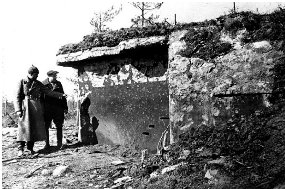
Финский пулеметный капонир Ink7, весна 1940 года. Обратите внимание на малые размеры пулеметных амбразур в бронестенке. ЦГАКФФД Спб.
