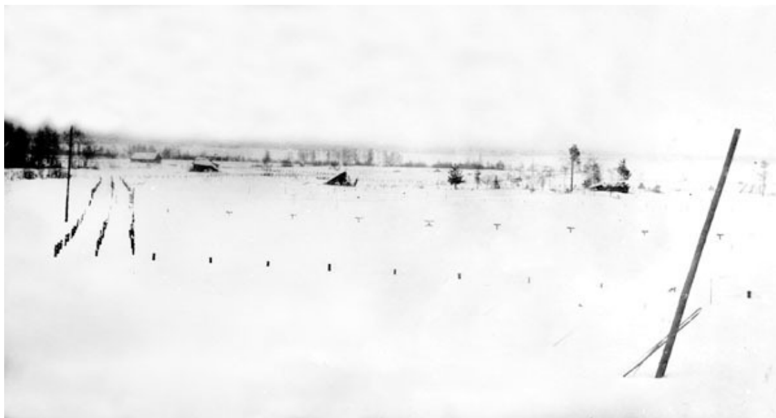
Финские проволочные заграждения и Т-образные вешки-маркеры для прицеливания из ДОТ, Муолаа. Из коллекции полковника Е. К. Скворцова
