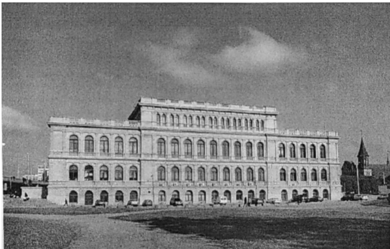
Здание Кёнигсбергской биржи
