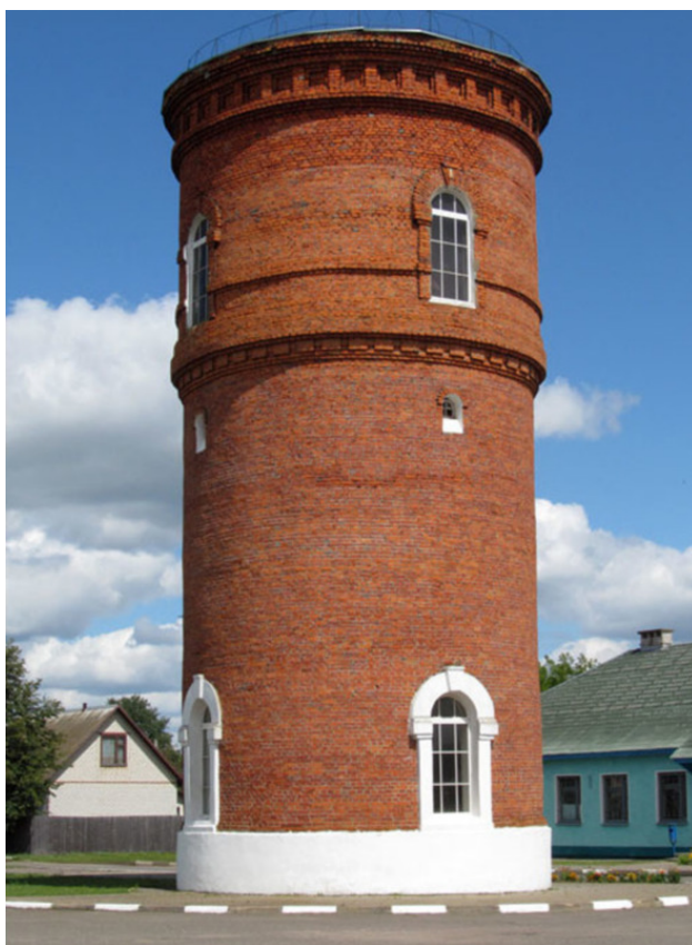
Водонапорка (судя по всему, дореволюционная). Nordprod. Источник: https://russiantowns.livejournal.com/5900002.html
