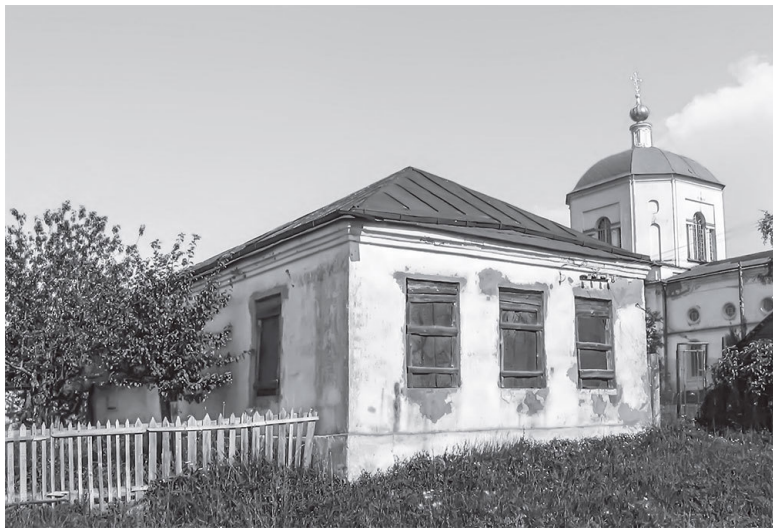
Здание бывшей церковно приходской школы в с. Ильинском. Фото 2004 г.
