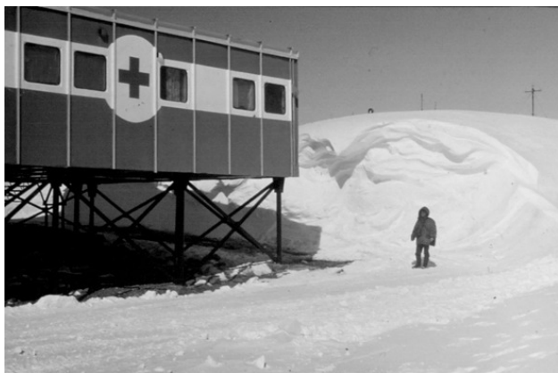
Здание медицинского центра на металлических сваях
