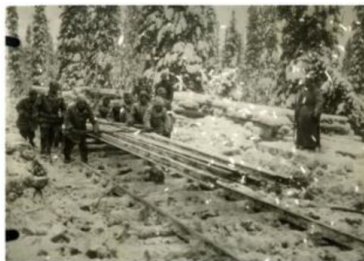
Работают заключённые, справа - конвой.
