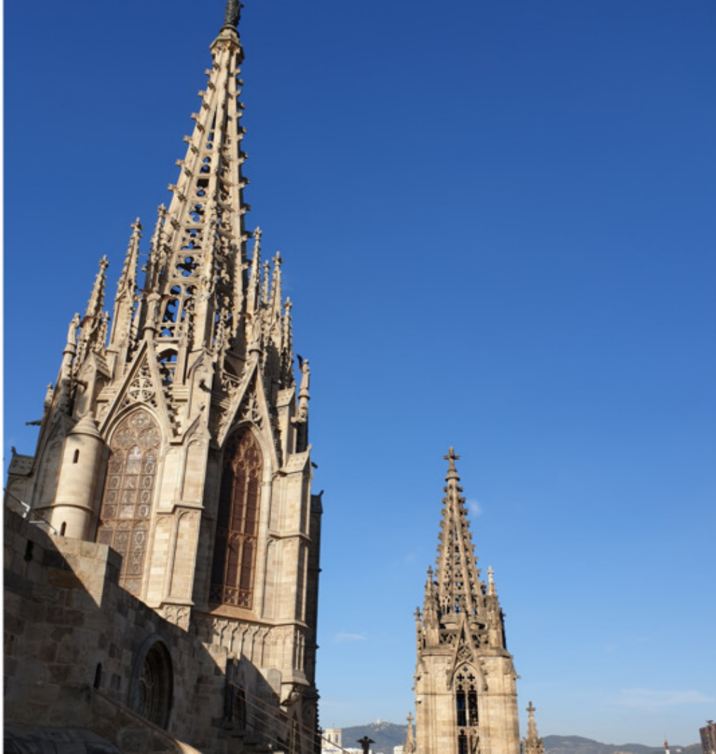
Шпили собора – вид с крыши
