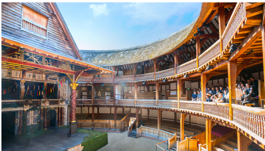
Реконструкция театра «Глобус»
