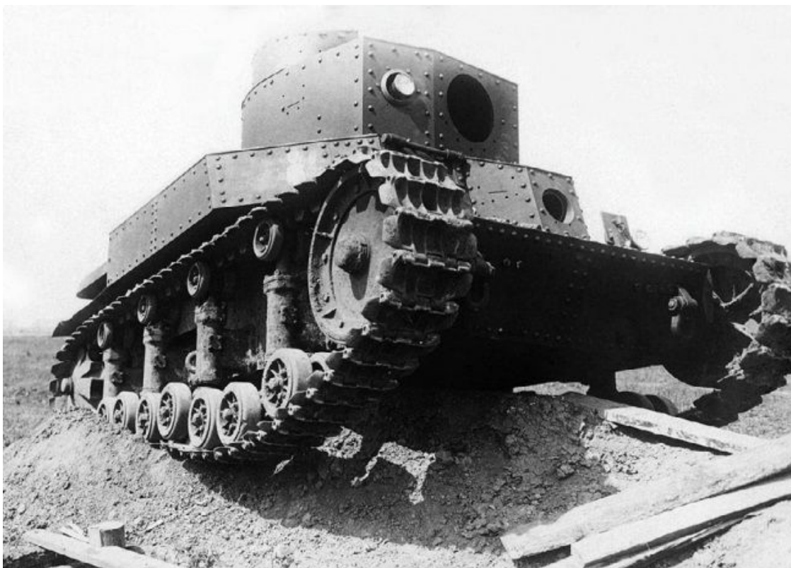
Танк Т-24 преодолевает окоп. Район Харькова, 18 июля 1931 года. Машина не имеет вооружения, а вместо башенного пулемета установлена фара.
