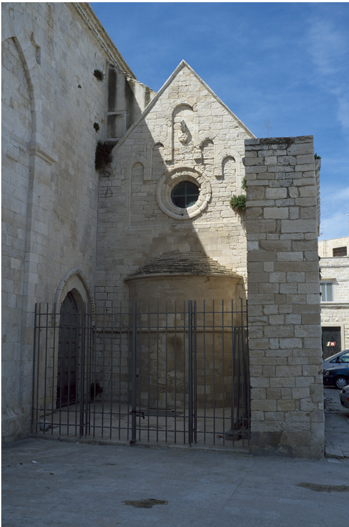
Рисунок 8 Пристройка на южном фасаде
