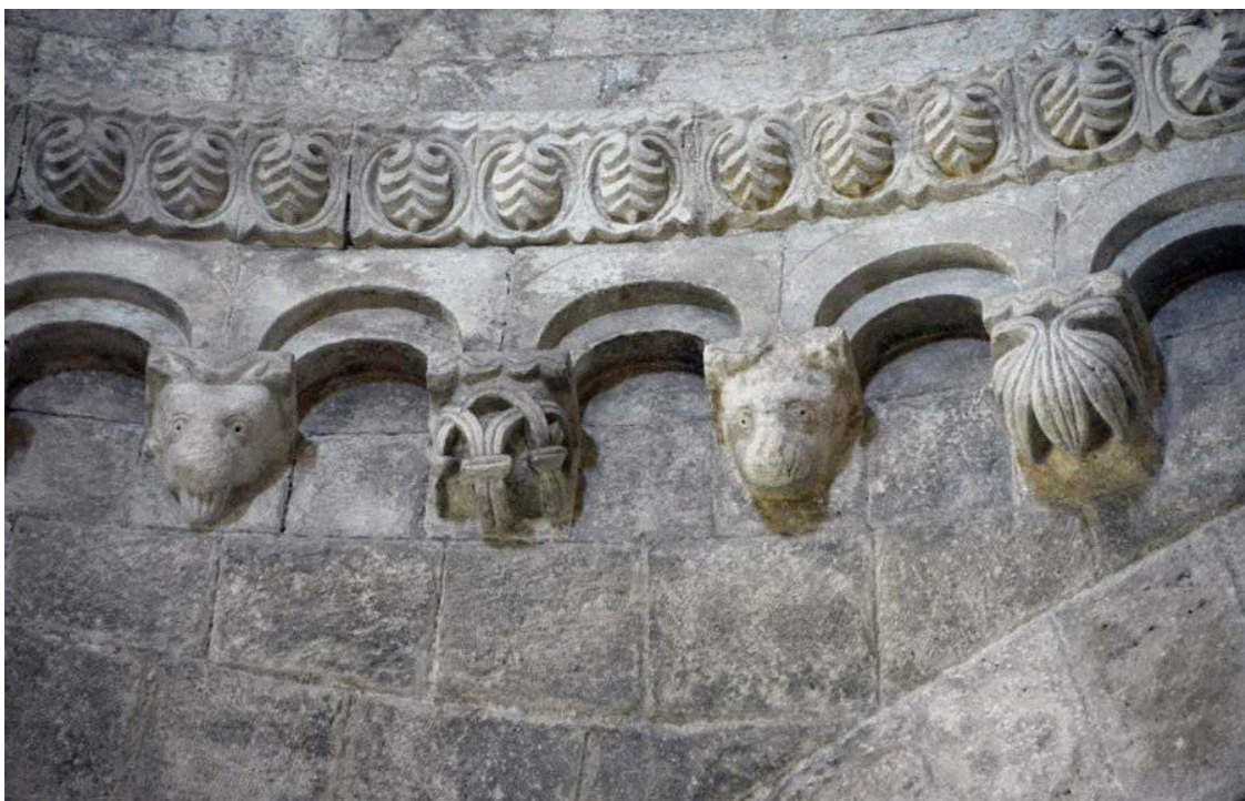
Рисунок 28 Карниз основания купола
