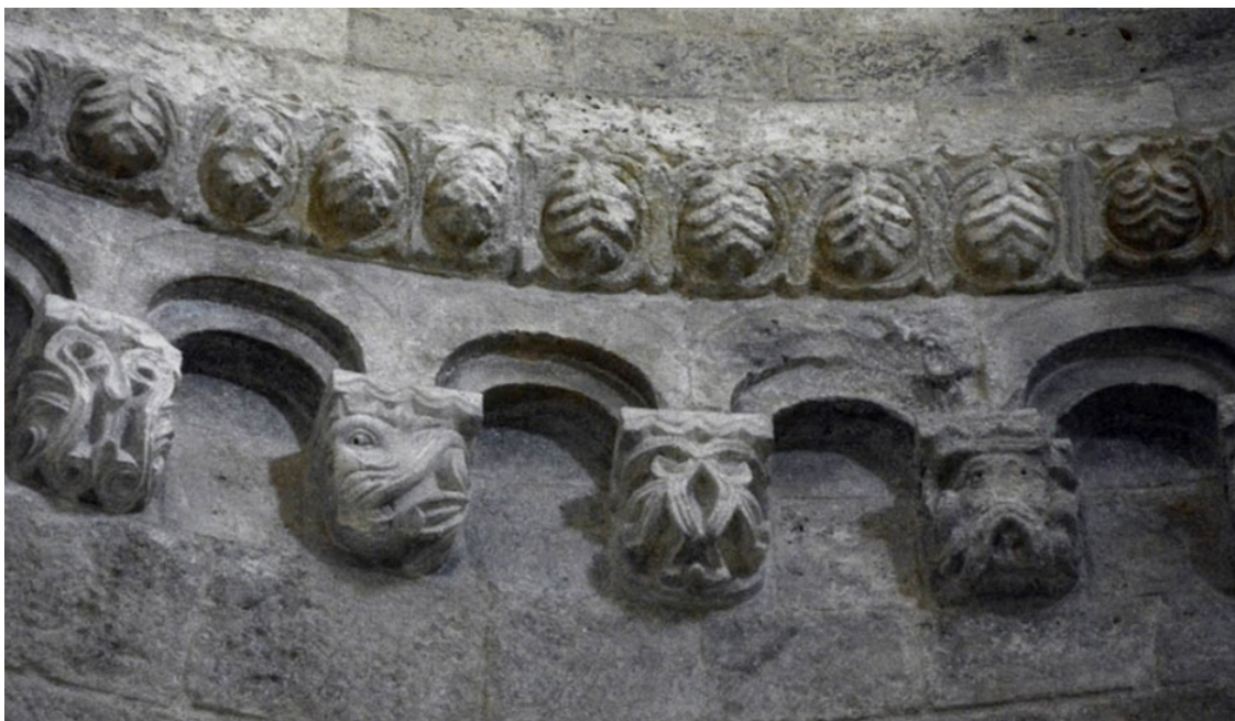
Рисунок 29 Карниз основания купола
