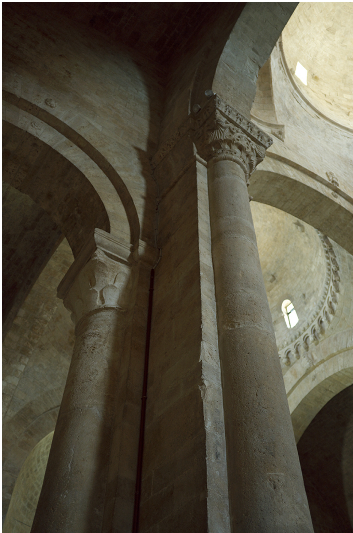
Рисунок 16 Опоры сводов
