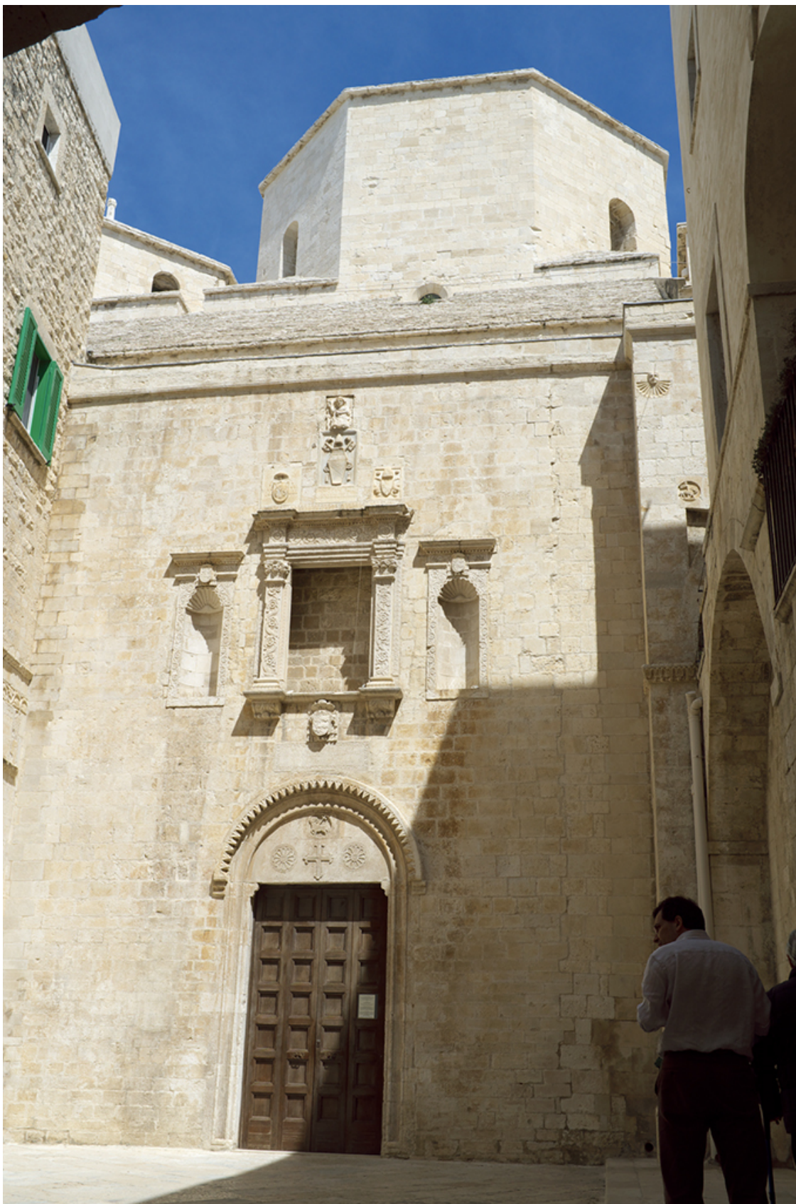
Рисунок 12 Фрагмент северного фасада. Вход в храм
