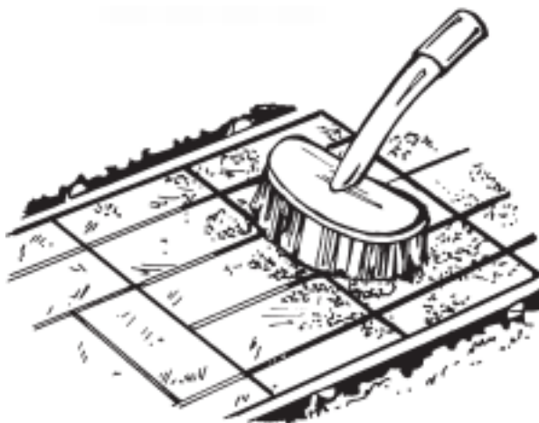
Рис. 18. Заполнение вертикальных стыков
